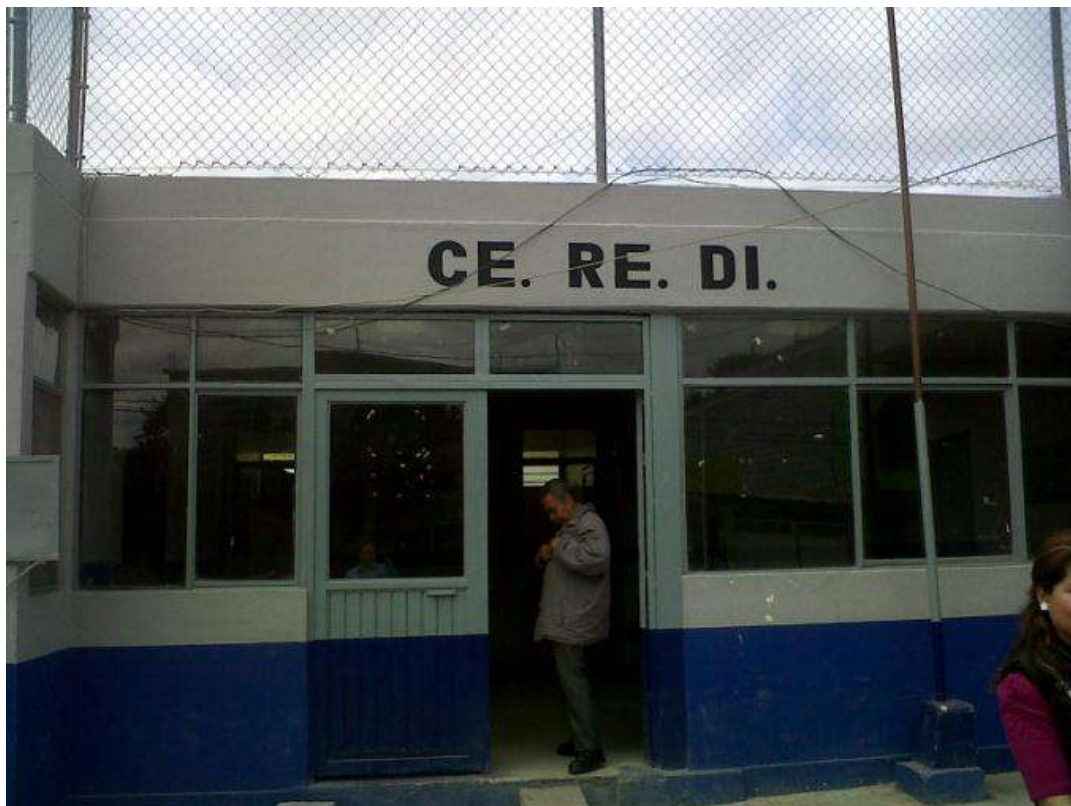
Exterior del CEREDI - Cárdenas
