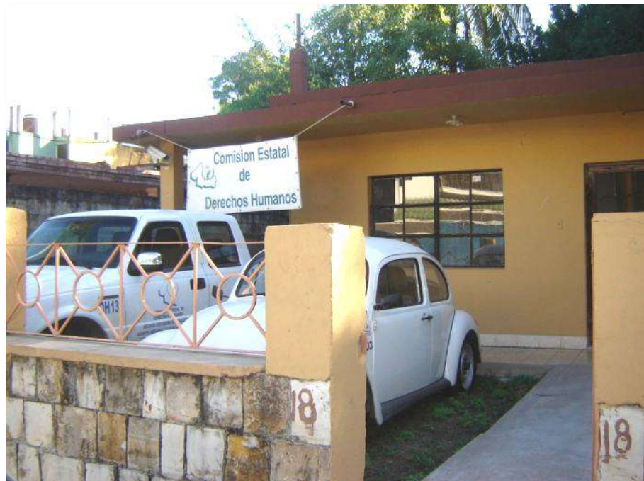
Fachada de las oficinas de la Segunda Visitaduría General. Ciudad Valles, S.L.P. Diciembre 2009.
